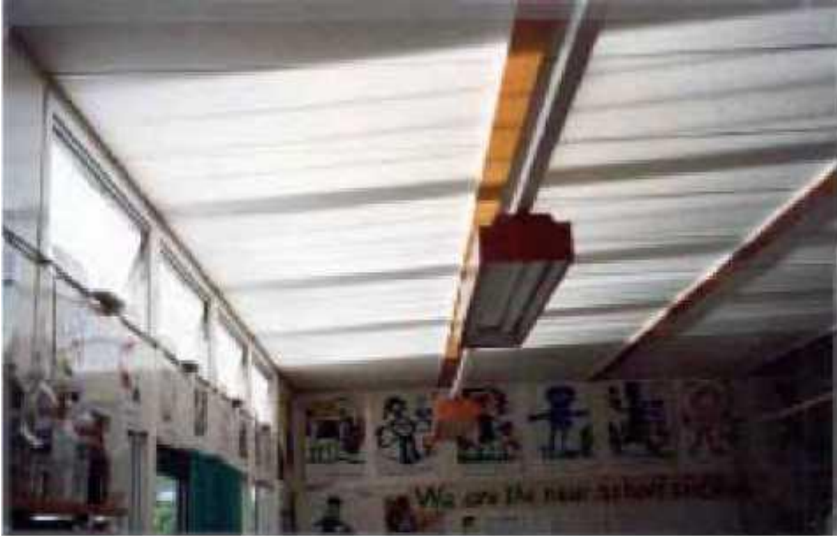
Şekil 11. Laseer Fason Panel Metodunda Güneş Işınlarının Oda İçerisinde Yönlendirilmesine Dair Örnek Bir Uygulama
