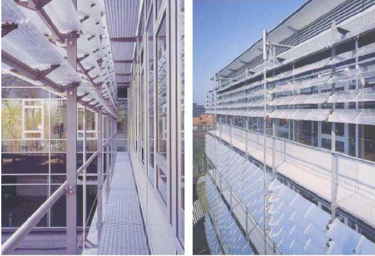
Şekil 9. Prizmatik Panel Metodu İle Uygulamaya Sokulan Gölge Yönteminin Gösterildiği Bir Örnek
