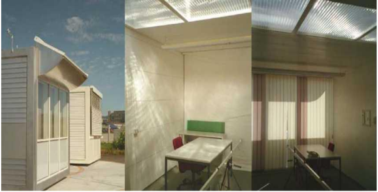
Şekil 5. Anidolik Açıklık Metodunda Yayılımlı Güneşin Odanın İçerisine Girdiğini Gösteren Bir Örnek Uygulama
