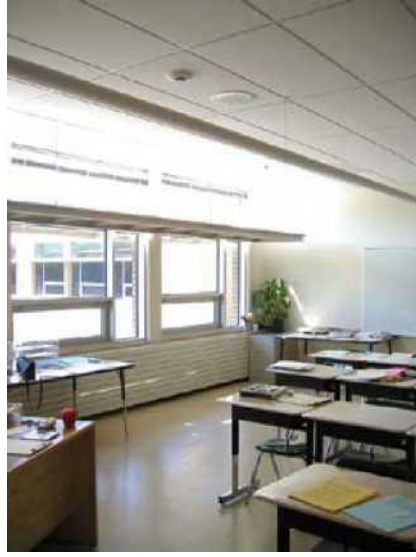
Şekil 2. Ash Creek Intermediatate Okulu Aydınlatma Laboratuvarı Işık Rafı Uygulaması (Londra-İngiltere)
